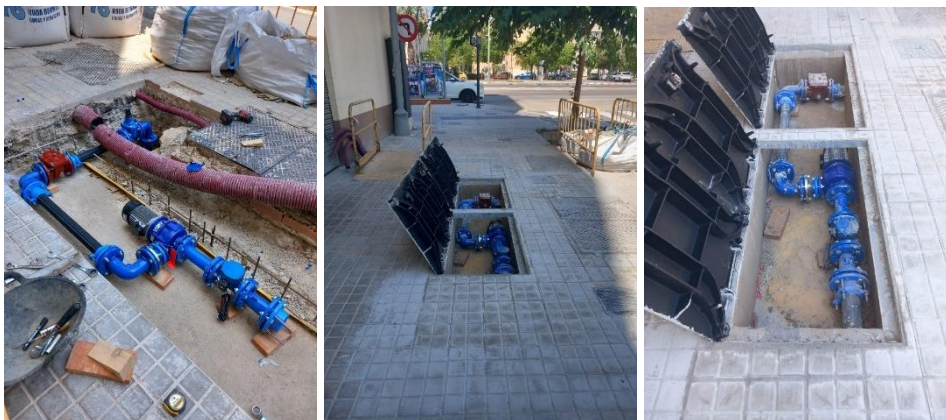
Figura 14. Turbina Instalada en Valencia. C/ Conde Melito Fuente: Propia
