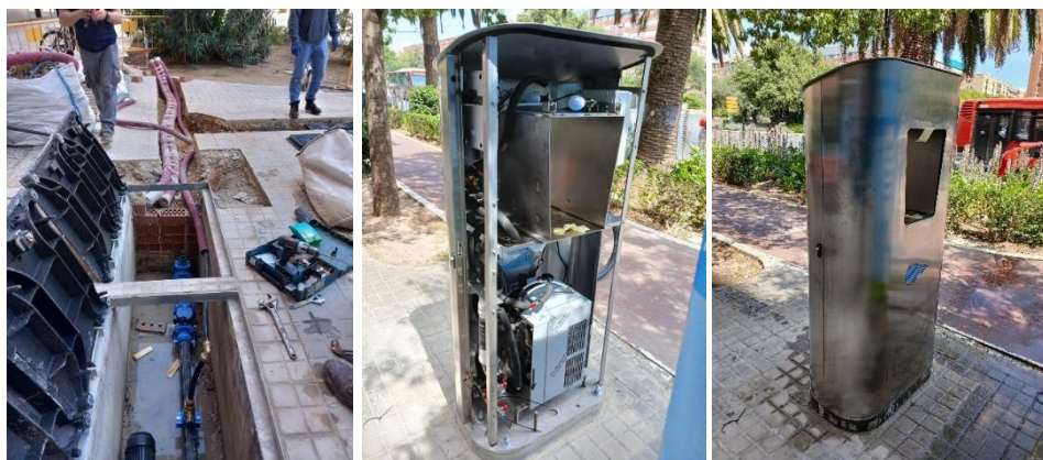
Figura 10. Turbina Instalada en Valencia. Av. Blasco Ibáñez – C/ Dr. Manuel Candela Fuente: Propia
