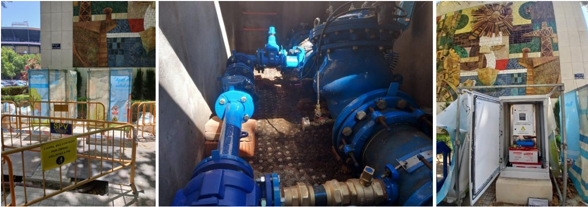
Figura 11. Turbina Instalada en Valencia. Av. Blasco Ibáñez – Av. Suecia Fuente: Propia
