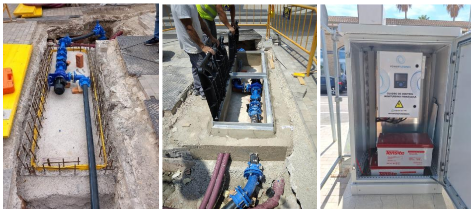
Figura 15. Turbina Instalada en Valencia. C/Pedro de Valencia
