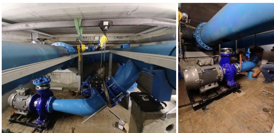
Figura 17. Turbina Instalada en Feria de Muestras. C/ Cullera, Benimàmet Fuente: Propia
