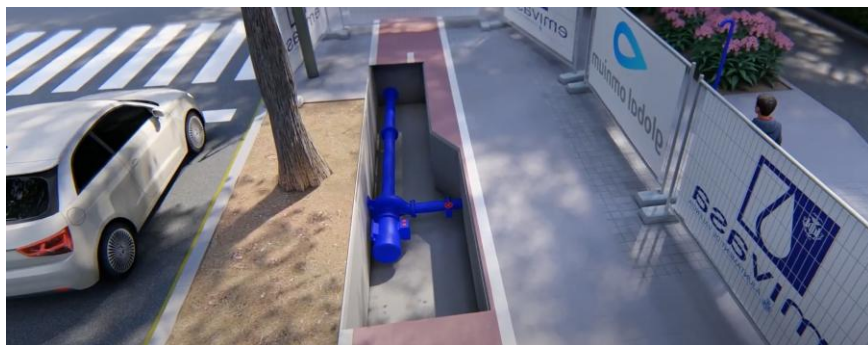
Figura 4. Turbina instalada en la AV. Cortes Valencianas.
